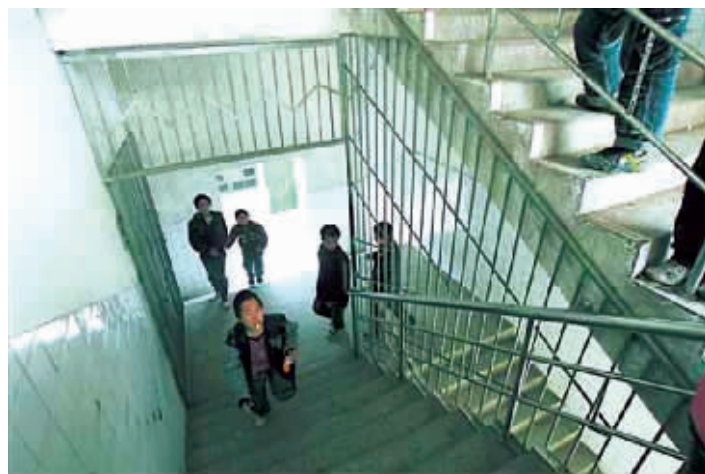
■发生踩踏事故的楼梯间
