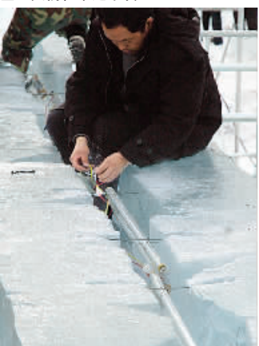
在冰墙内安装灯管
